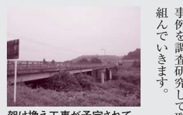
架け換え工事が予定されている富川橋
